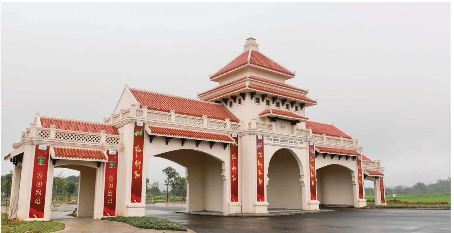
Cổng số 1 tại nút giao giữa ĐHQGHN với đại lộ Thăng Long kéo dài lấy cảm hứng từ kiến trúc tòa nhà Đại học Đông Dương tại số 19 phố Lê Thánh Tông, Hà Nội.
